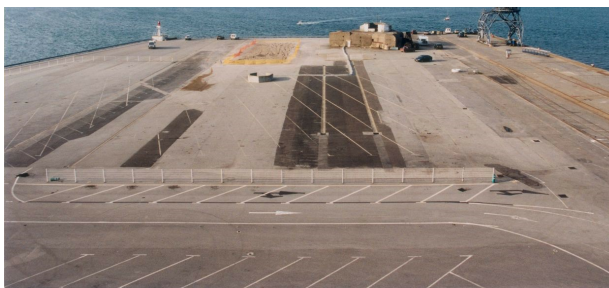
Construction de la darse du Redoutable à La Cité de la Mer © Joël LEHUBY
