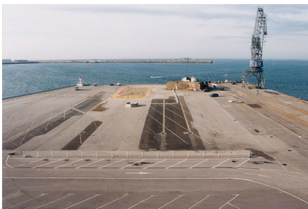
Construction de la darse du Redoutable à La Cité de la Mer © Joël LEHUBY
